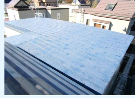
屋根塗装 塗装前
